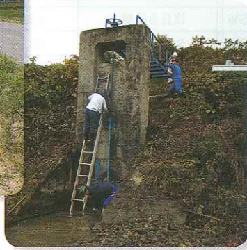
取水口の管理
