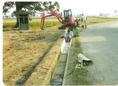
破損施設の補修
