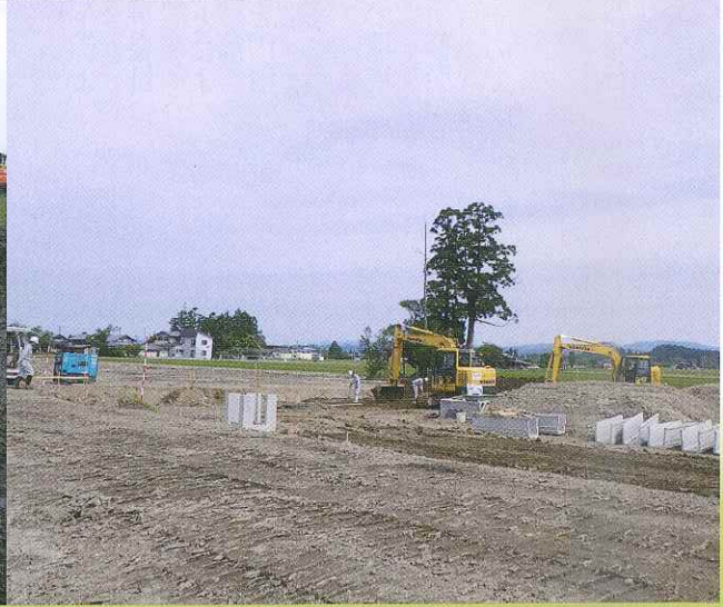
畑屋中央地区の工事状況
