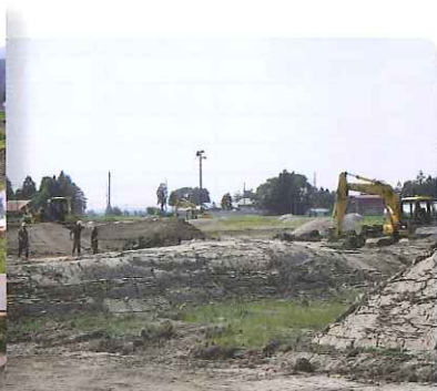
大畑地区の工事
