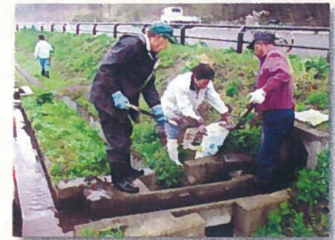
水路浚渫 (外川原)
