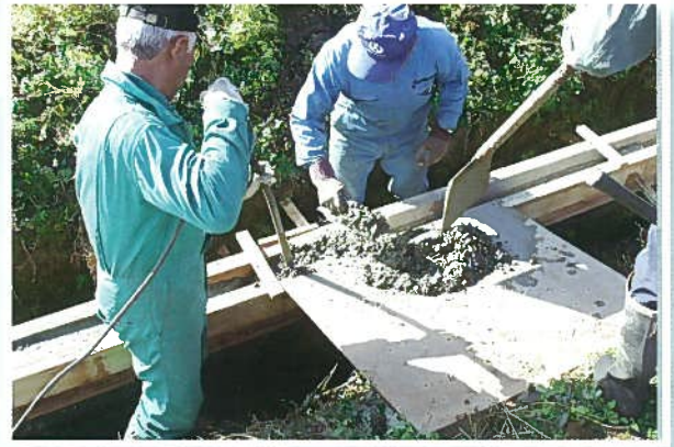
補修をして老朽施設の長命化（中野）
