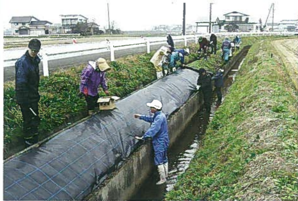
防草シートで作業軽減（羽貫谷地）
