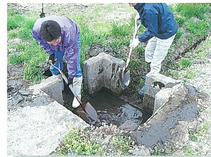
水路の泥上げ作業 (羽貫谷地)
