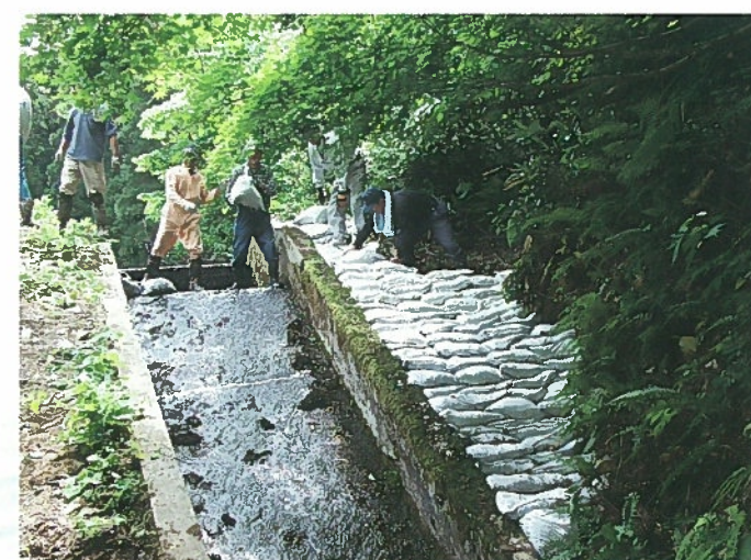
ため池の法面補修 (湯竹)
