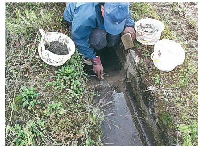
水路の目地補修 (安城寺)
