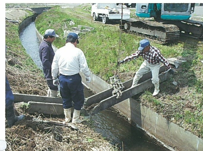
破損した施設を補修整備 (中野)
